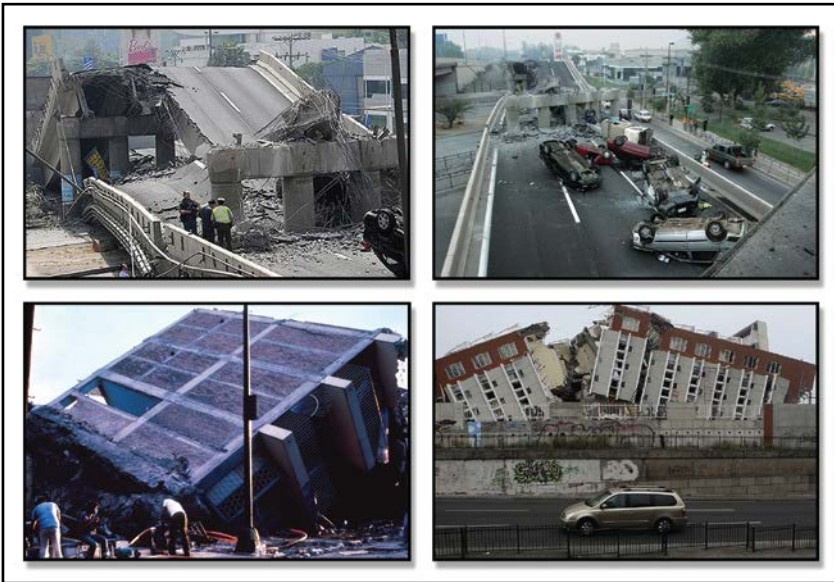
איור 5.5: דוגמאות ל"הפיכה" לאחר רעידת אדמה. (צד ימין למעלה: Lednicer, 2010; צד שמאל למעלה: Dolasia, 2010; צד ימין למטה: Chinahourly, 2014; צד שמאל למטה: CK-12, 2012)
